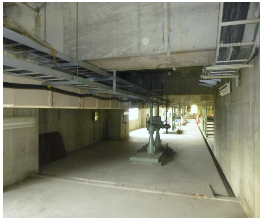
施工後：止水状況 (1年経過 平成30年11月時点)
