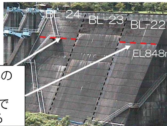
スラストブロック背面状況
