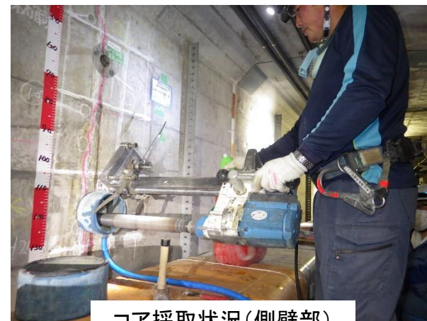
コア採取状況(側壁部)
