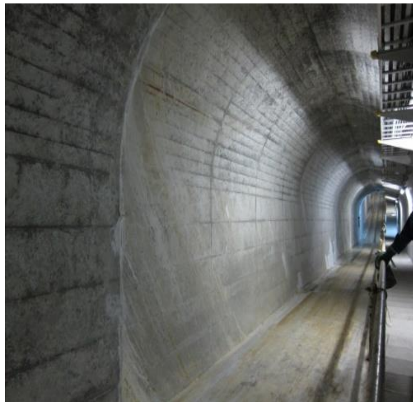
2013年12月(施工後) 漏水なし
