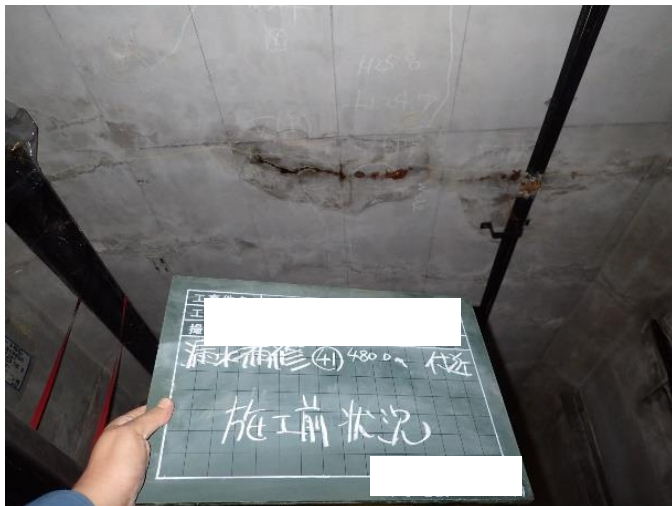
ひび割れ漏水補修 施工前
