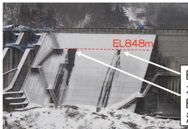
スラストブロック背面状況
