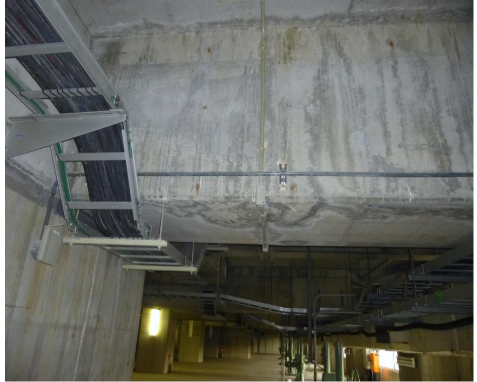
施工後：止水状況 (1年経過 平成30年11月時点)
