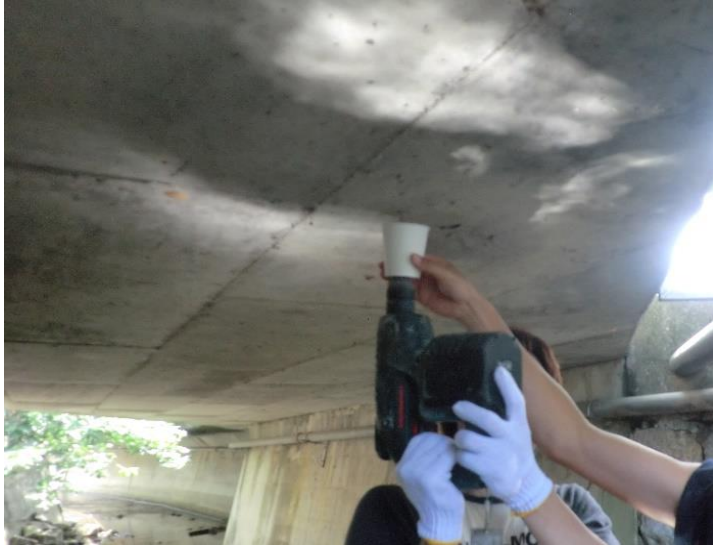
コンクリート粉末の採取状況
