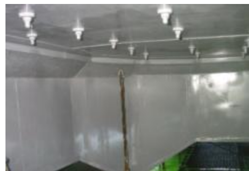
天井部 GFプロテクト施工
