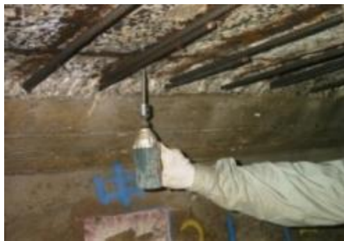
鉄筋新設
