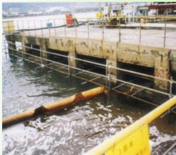
施工前(全体像)
