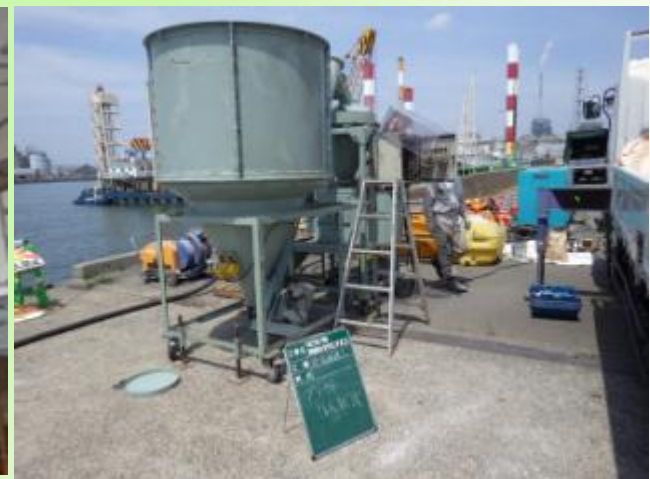
グラウト注入
