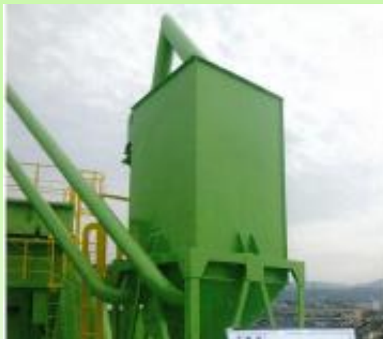
セメントサイロ 施工後
