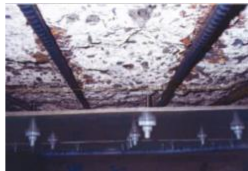
埋込型枠加工取付(GMP板=7mm)
