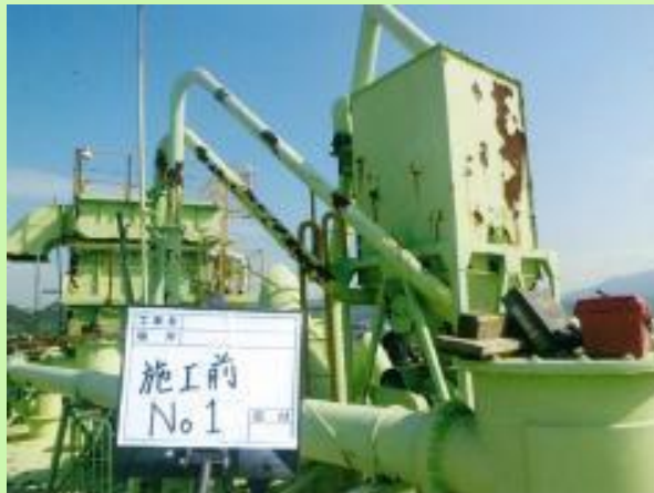
セメントサイロ 施工前
