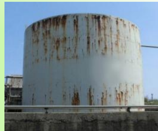
化学工場 施工前
