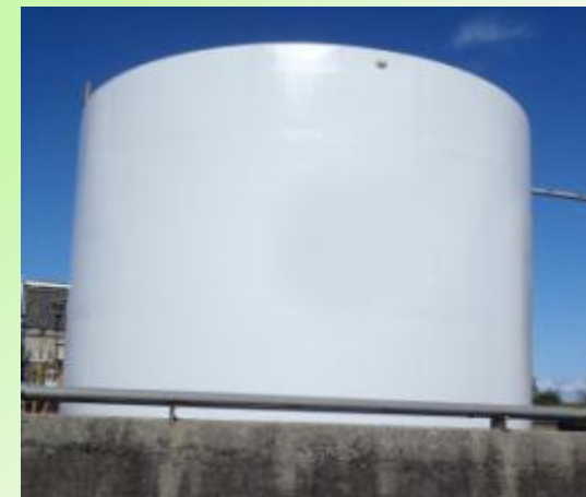
化学工場 施工後
