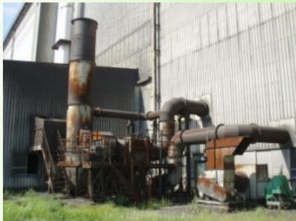
屋外排気設備 施工前
