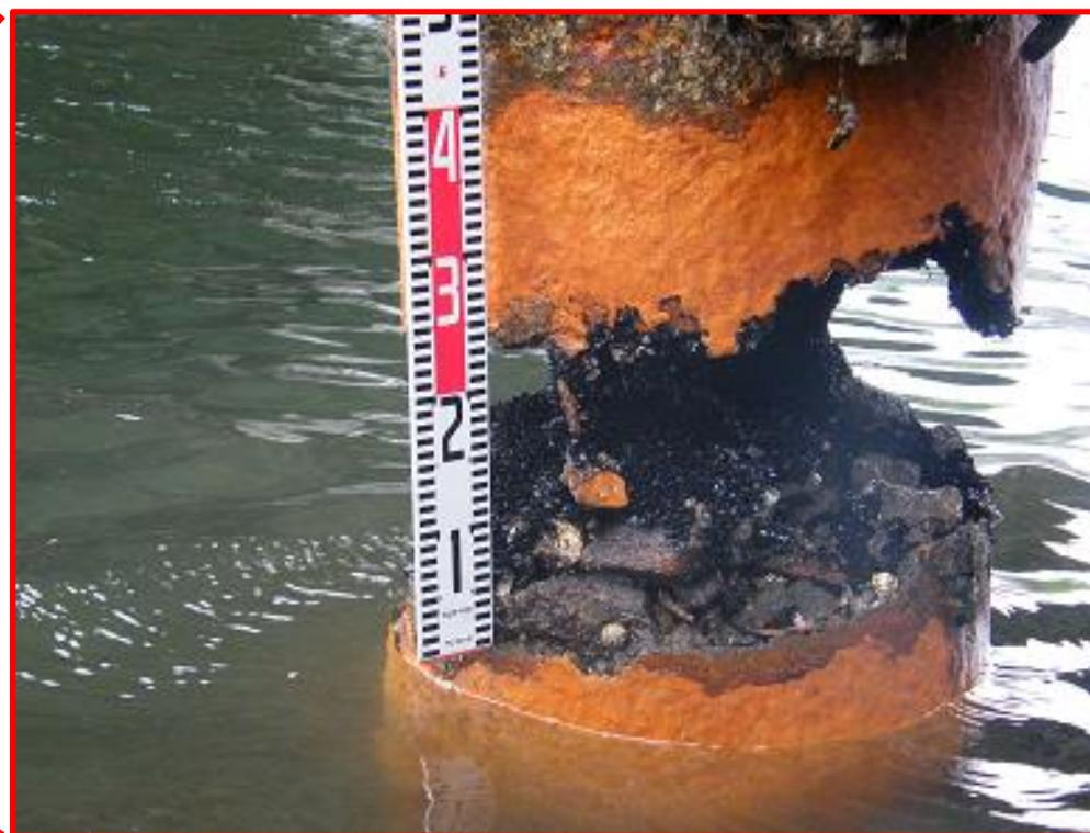
※水中部から調査を実施したところ鋼製杭橋脚に著しい腐食が確認
