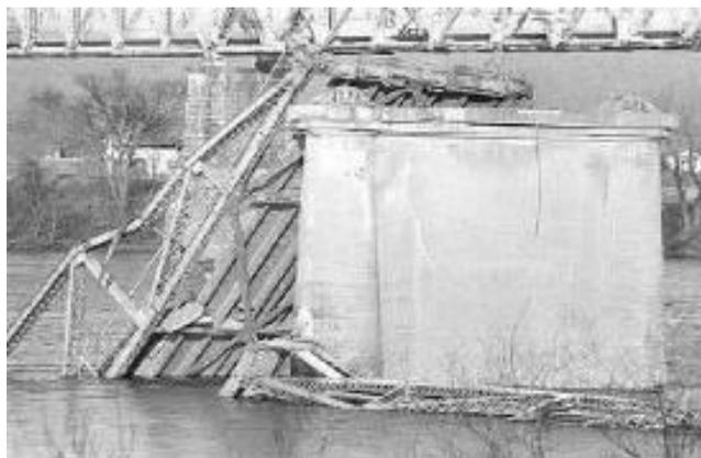
ケーブルの疲労（破壊）により落橋
