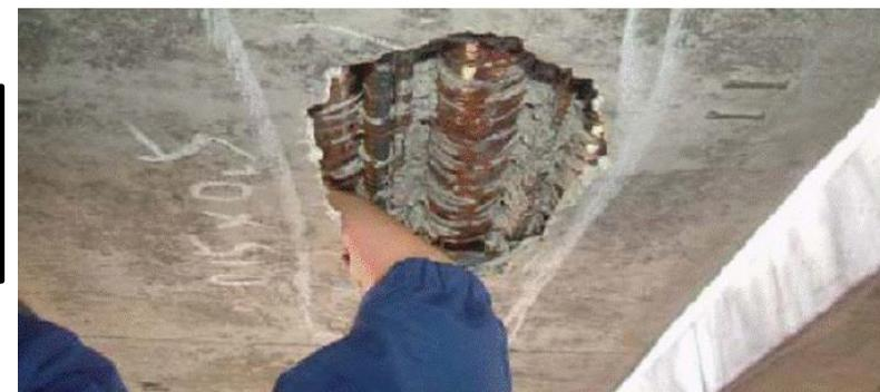
近接目視であれば、触診や打音検査を併用することによって正確な点検を行うことが可能
