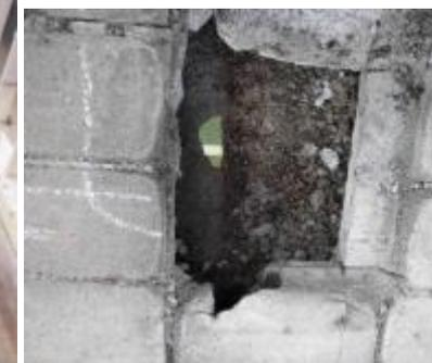
浸入した雨水等による凍結・融解の繰り返して脆弱化した可能性が高いコンクリートが土砂化し生じた空洞
