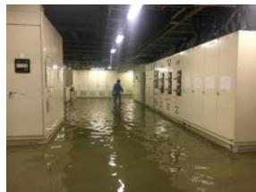
地下電源設備の浸水被害
