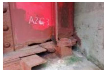
桁端部の腐食・貫通
