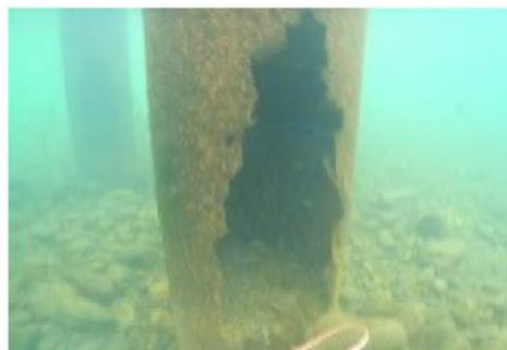
▲パイルベントの断面欠損
