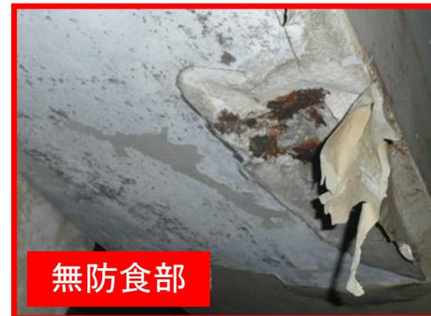
**原因** 外電不溶性陽極による電気化学反応： $\text{H}_2\text{O} \rightarrow 1/2\text{O}_2 \uparrow + 2\text{H}^+ + 2\text{e}^-$
