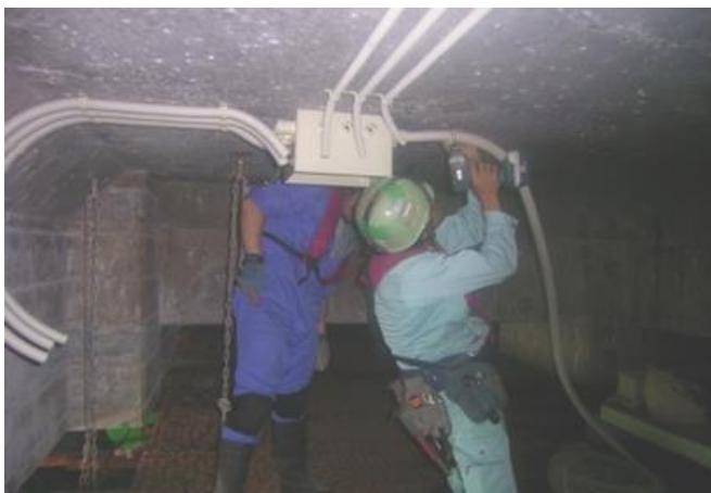
コンダクターバーとリード線をプルボックス内で結線し、直流電源装置まで配線配管を行う。
