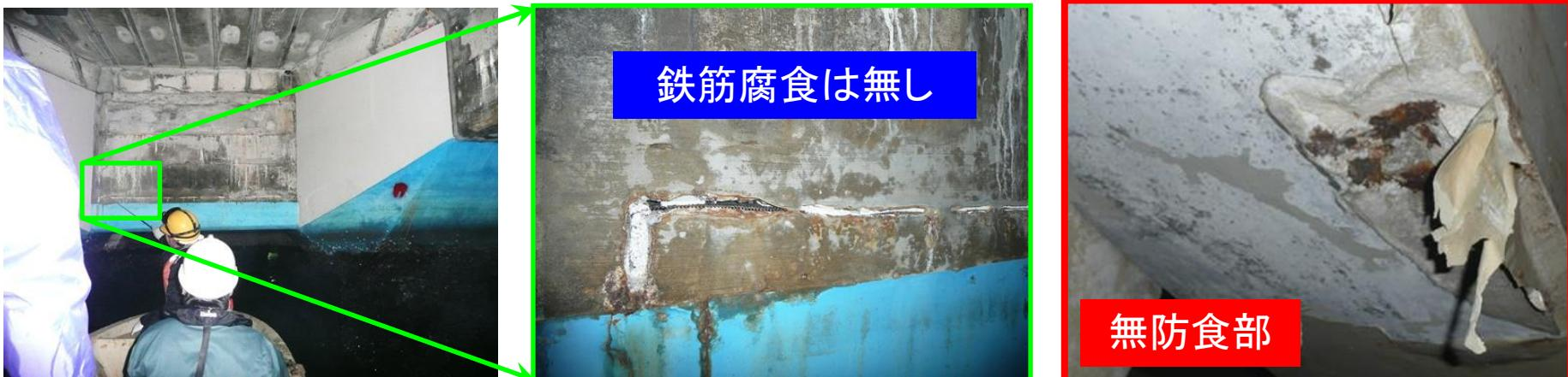
**原因** 外電不溶性陽極による電気化学反応:  $\text{H}_2\text{O} \rightarrow 1/2\text{O}_2 \uparrow + 2\text{H}^+ + 2\text{e}^-$
