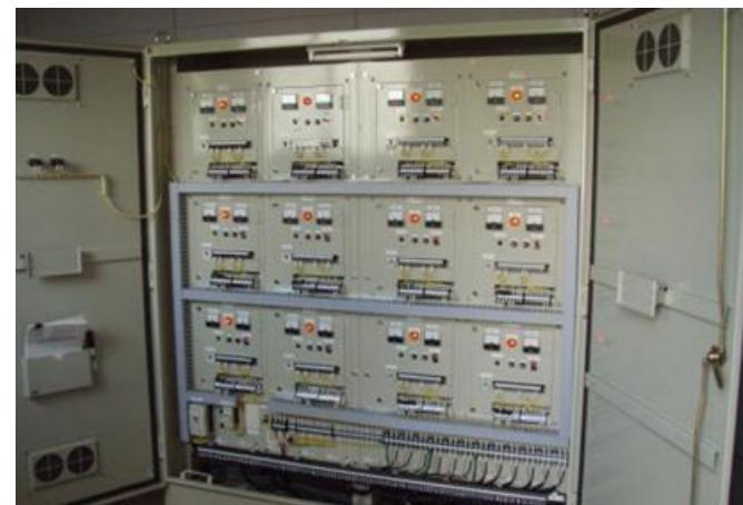
直流電源装置の設置、配線の接続を行う。通電調整試験によって防食電流を決定し、通電する。
