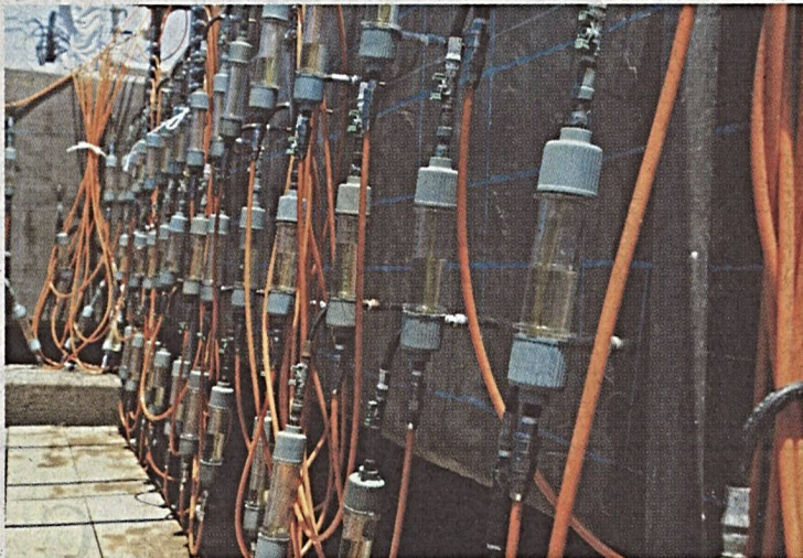
空圧機器で高圧注入するタイプの「リハビリカプセル工法」の施工現場
