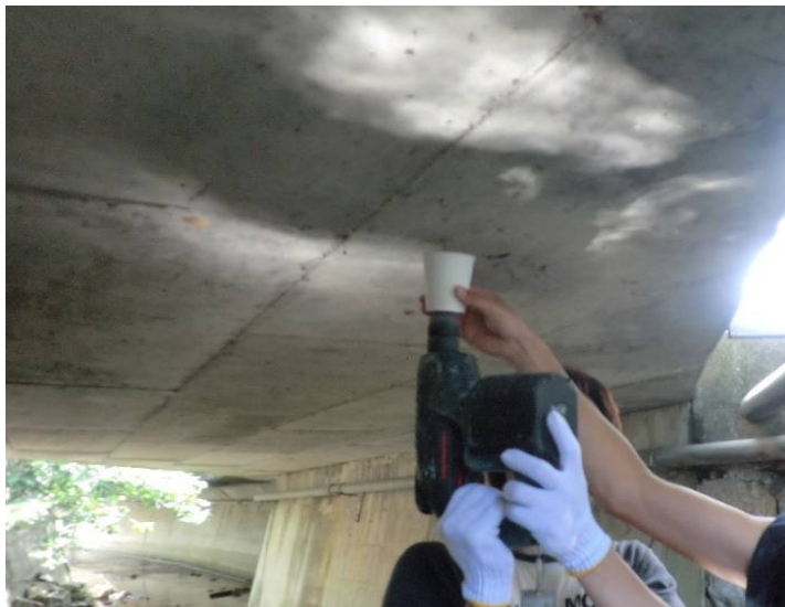
コンクリート粉末の採取状況
