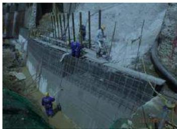
擁壁工 外壁の埋設型枠
