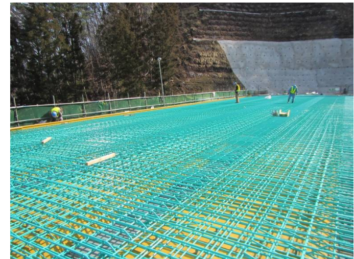
エポキシ鉄筋の適用例
