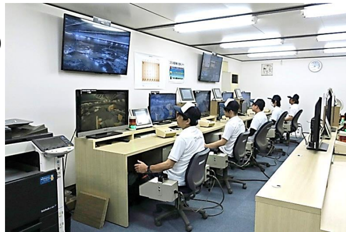
無人掘削 (遠隔操作)
