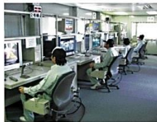
地上遠隔操作室
