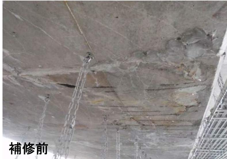
コンクリートの表面には、浮き、サビ汁、鉄筋の露出などが見られる。
