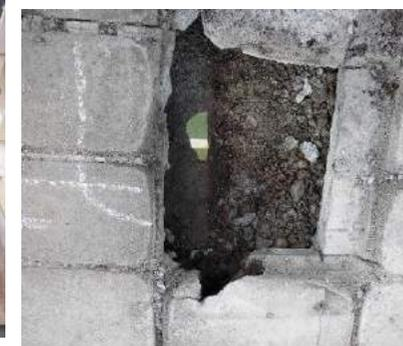
浸入した雨水等による凍結・融解の繰り返しで脆弱化した可能性が高いコンクリートが土砂化し生じた空洞
