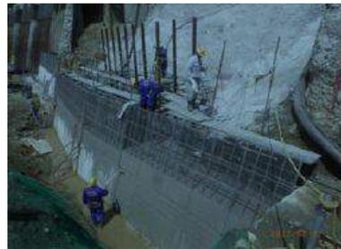
擁壁工 外壁の埋設型枠
