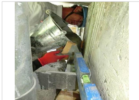
既設コンクリートT桁の支承取付部材への充填材として使用した例
