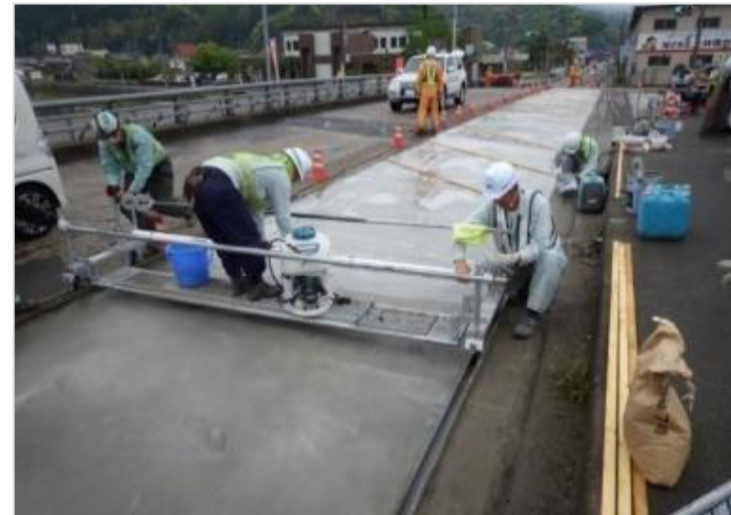
連続打設とシート養生
