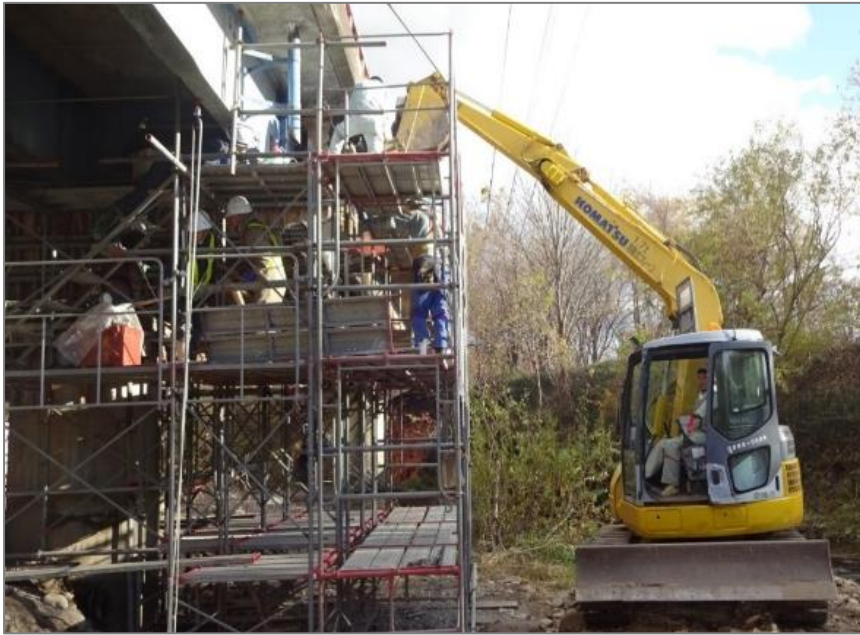
型枠を設置しJ-ティフコム®を流し込みで施工
