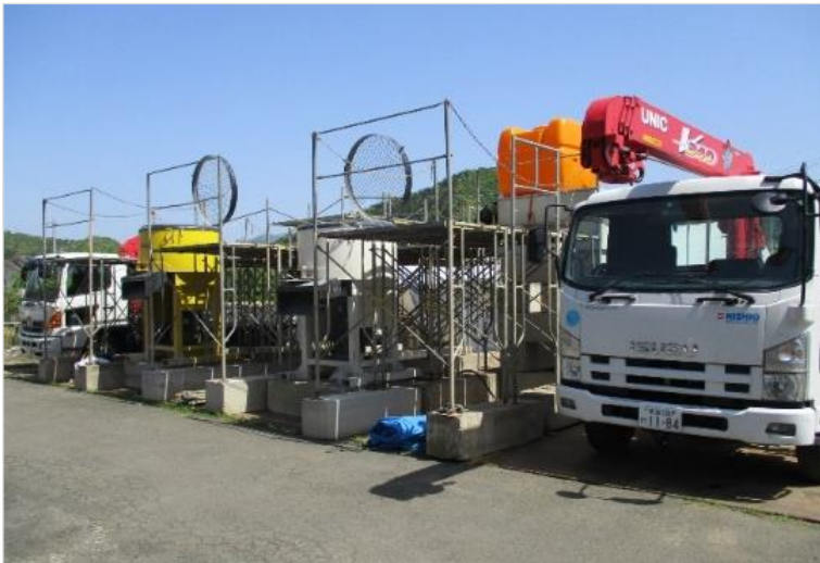
現場での練り混ぜ状況
