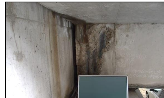
主桁の損傷
