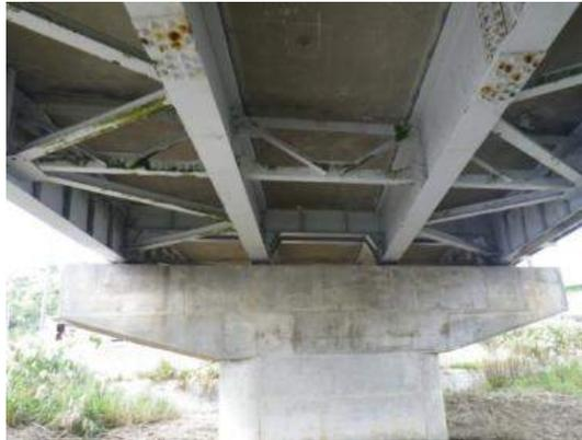
塩害による鋼材腐食、落橋防止システムの未設置
