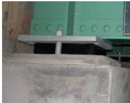
桁端部の当て板補強・塗装、
