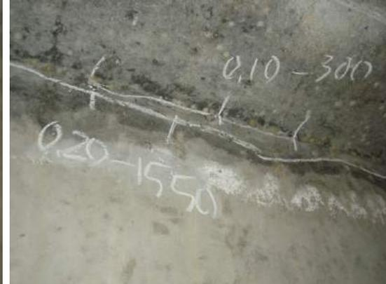
・近接目視によりひびわれが確認できた例
