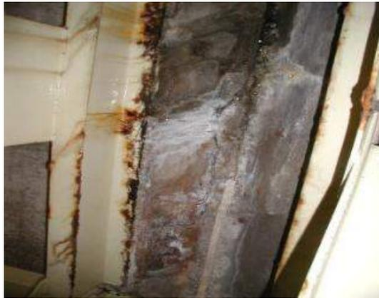
塩害によりコンクリート床版にひびわれ、うきが発生
