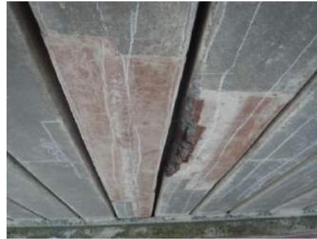
断面補修箇所(茶色)の再劣化
