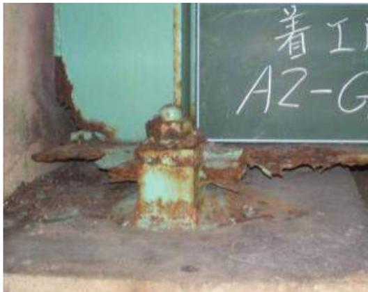
塩害による桁端部の腐食、
