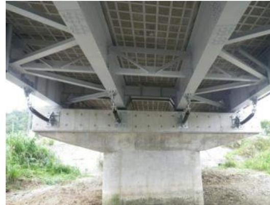
塗装塗替え、落橋防止システムの設置
