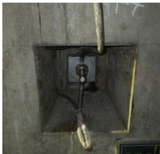
【PCグラウト注入状況】
