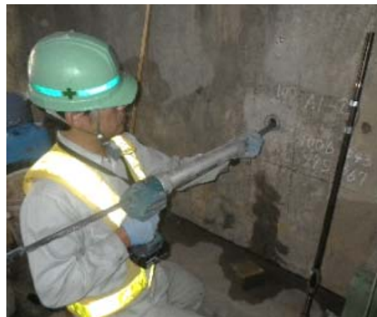
【先端部充填材注入状況】
