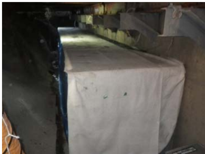
【増フーチングコンクリート養生状況】
