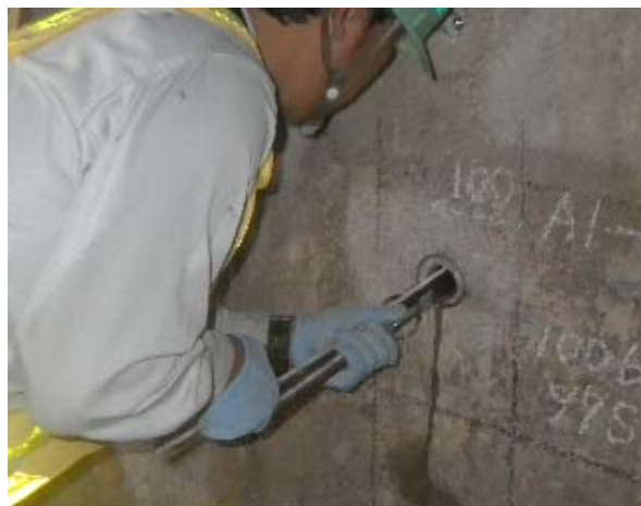
【緊張材の挿入】
