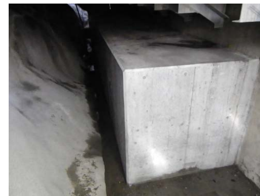
増しフーチング完了後
