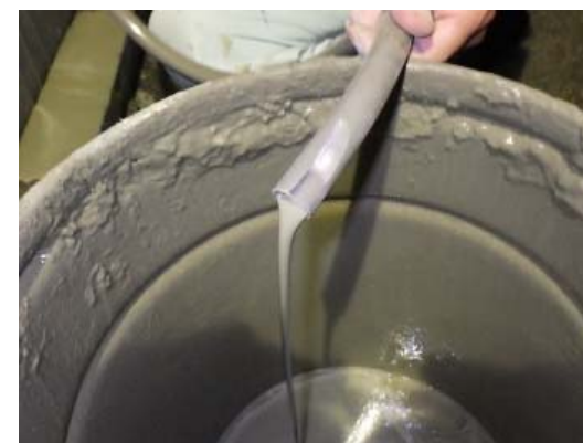
【グラウト排出確認】
