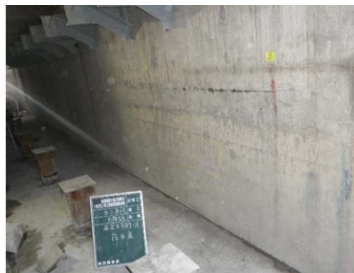
増しフーチング着手前 （増し杭完了）
