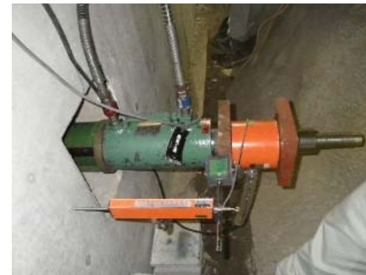
【緊張ジャッキ および計測機器】
