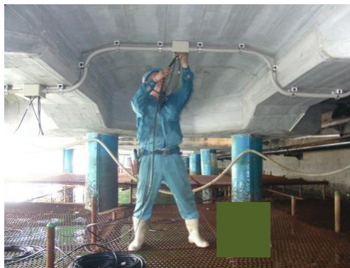
ブロック内 配線配管工 (RC栈橋部)
