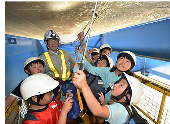
▲点検車による床版の叩き点検
