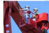
直轄診断(三島大橋)
