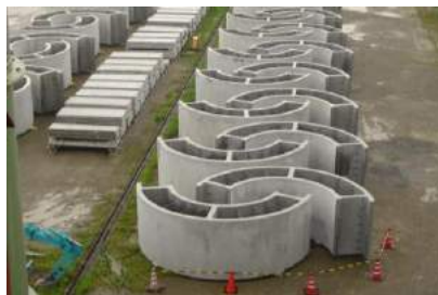
工場から現地に搬入
