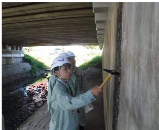
▲橋台・橋脚の打音検査を体験
