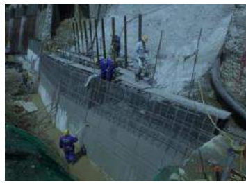
擁壁工 外壁の埋設型枠
