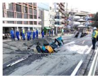
埋設管の老朽化に伴う道路陥没
