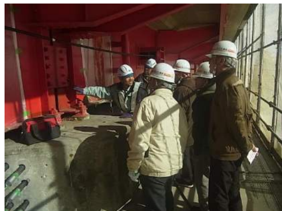
支承交換、落橋防止(省座拡幅)説明【平大橋】
