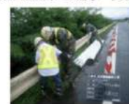
<防護柵の取替>
