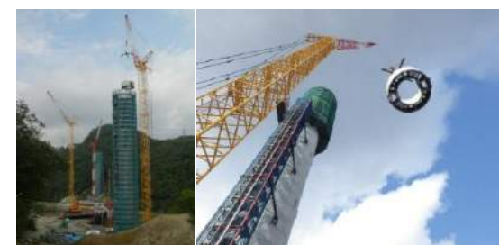
クレーンで吊り込み設置
