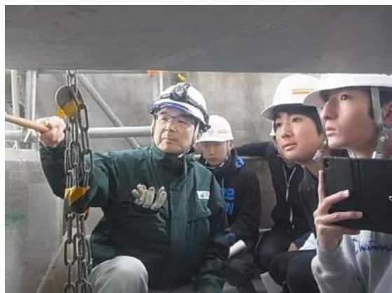
支承交換、補修(金属溶射)説明【平跨線橋】
