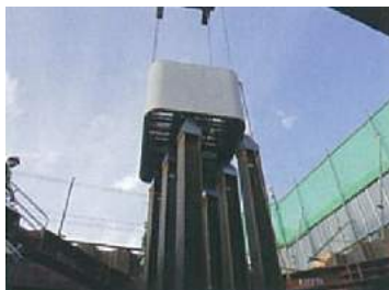
橋梁下部工 橋脚部の埋設型枠
