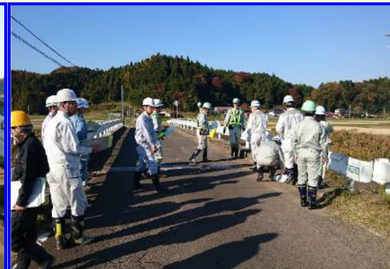
橋面舗装・防護柵
