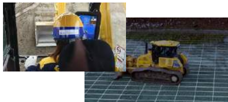
ICT建機による施工
