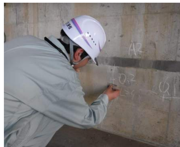
▲クラックスケールによるひび割れ計測の体験
