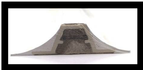
グラウト充填状況
