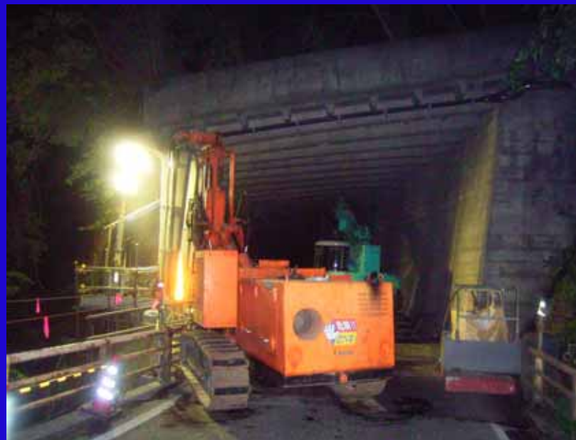
夜間施工状況
