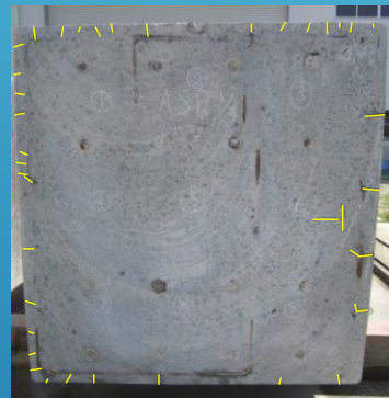
切断面の状況
