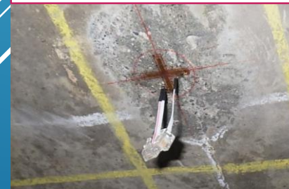
④配線取り外し
