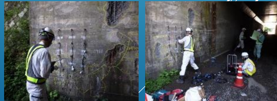
図- ドリル削孔状況
