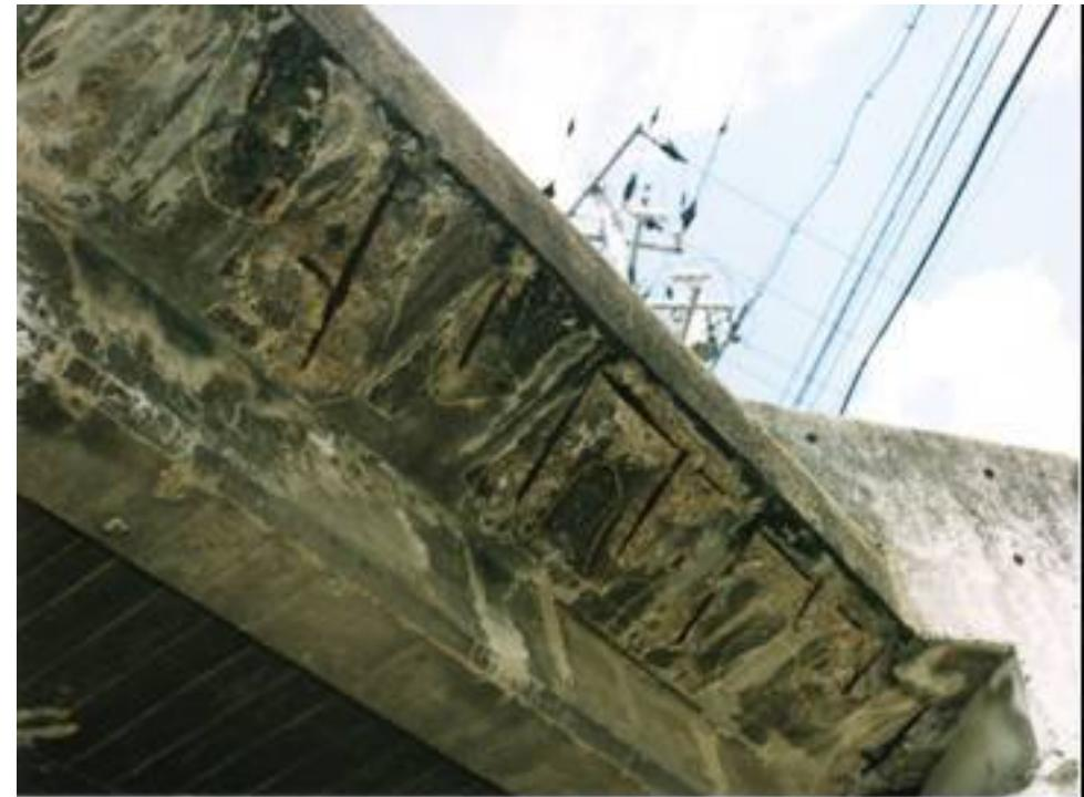
張出し床版下面の鉄筋露出
