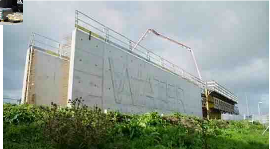
現場打ち防火水槽
