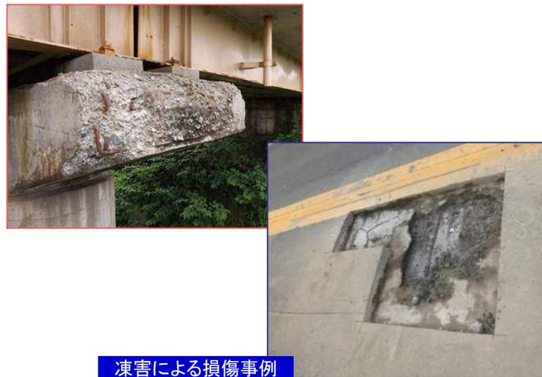
凍害による損傷事例
