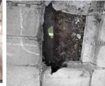
浸入した雨水等による凍結・融解の繰り返しで脆弱化した可能性が高いコンクリートが土砂化し生じた空洞
