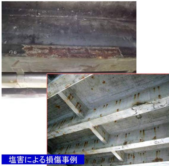
塩害による損傷事例
