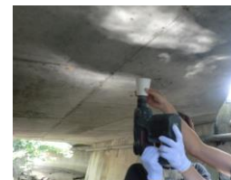
コンクリート粉末の採取状況
