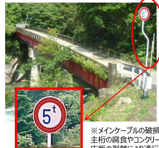
※メインケーブルの破損、主桁の腐食やコンクリート床版の剥離により通行規制を実施している事例
