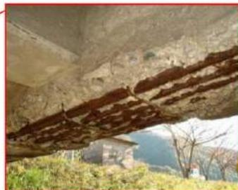
主桁の剥離、鉄筋露出
