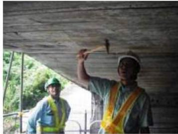
目視及びハンマーによる打音検査
