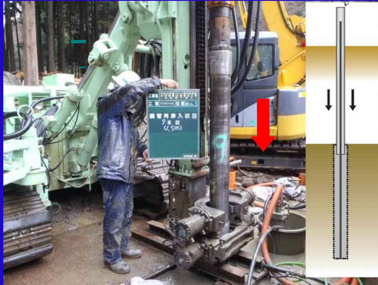
定着部内に設計で決められた長さ(1m以上)分の鋼管を再挿入する。
