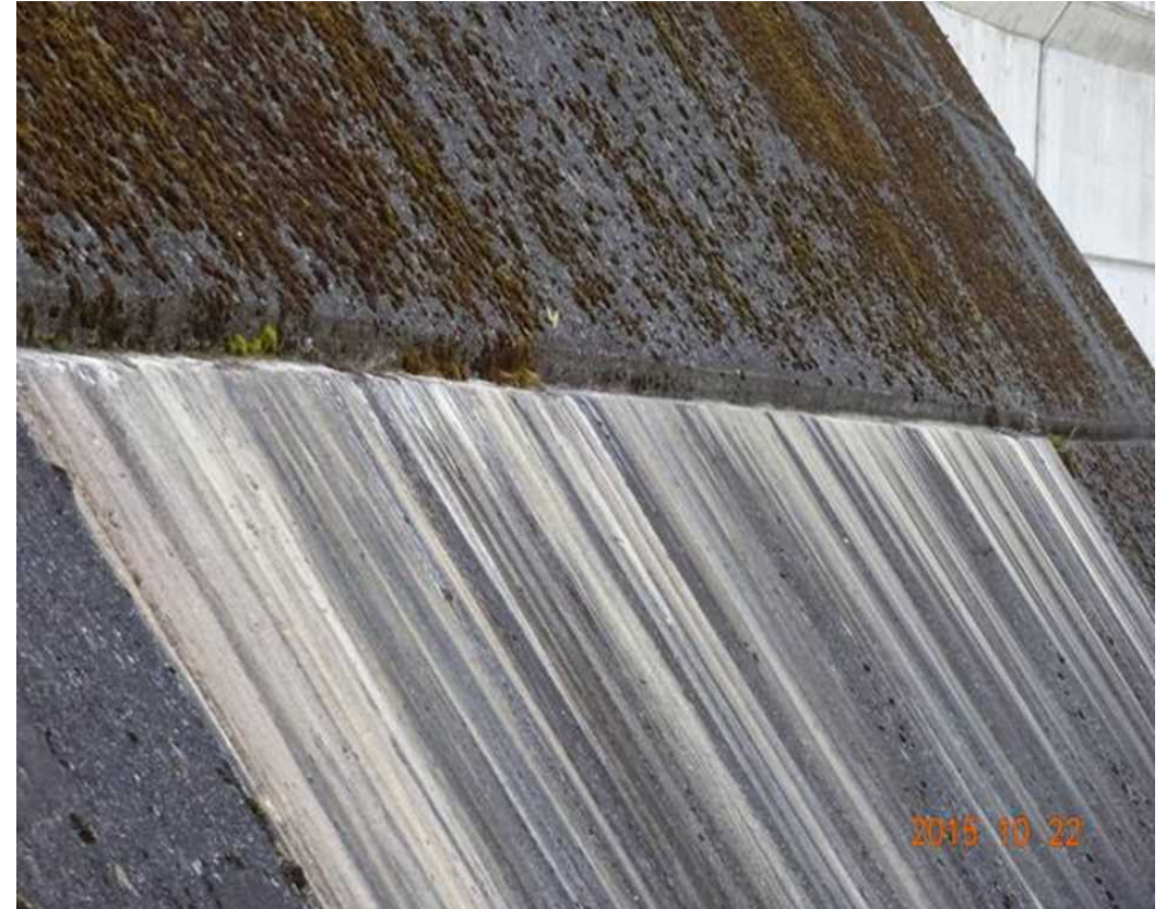
注入完了直後（リークした注入材除去前）
