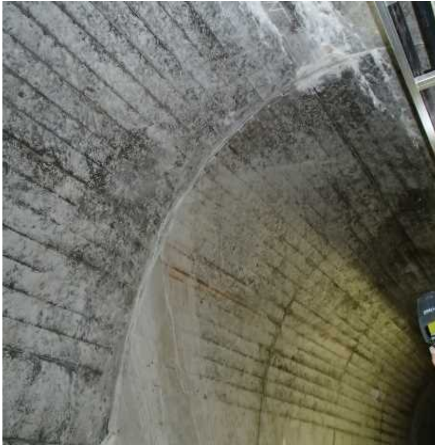
2014年12月（施工後） 漏水なし
