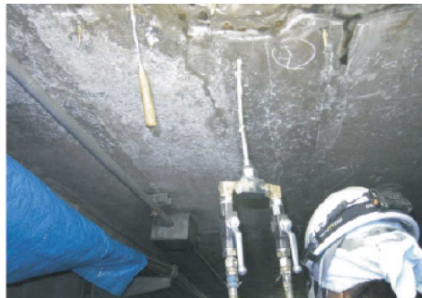
注入状況写真
