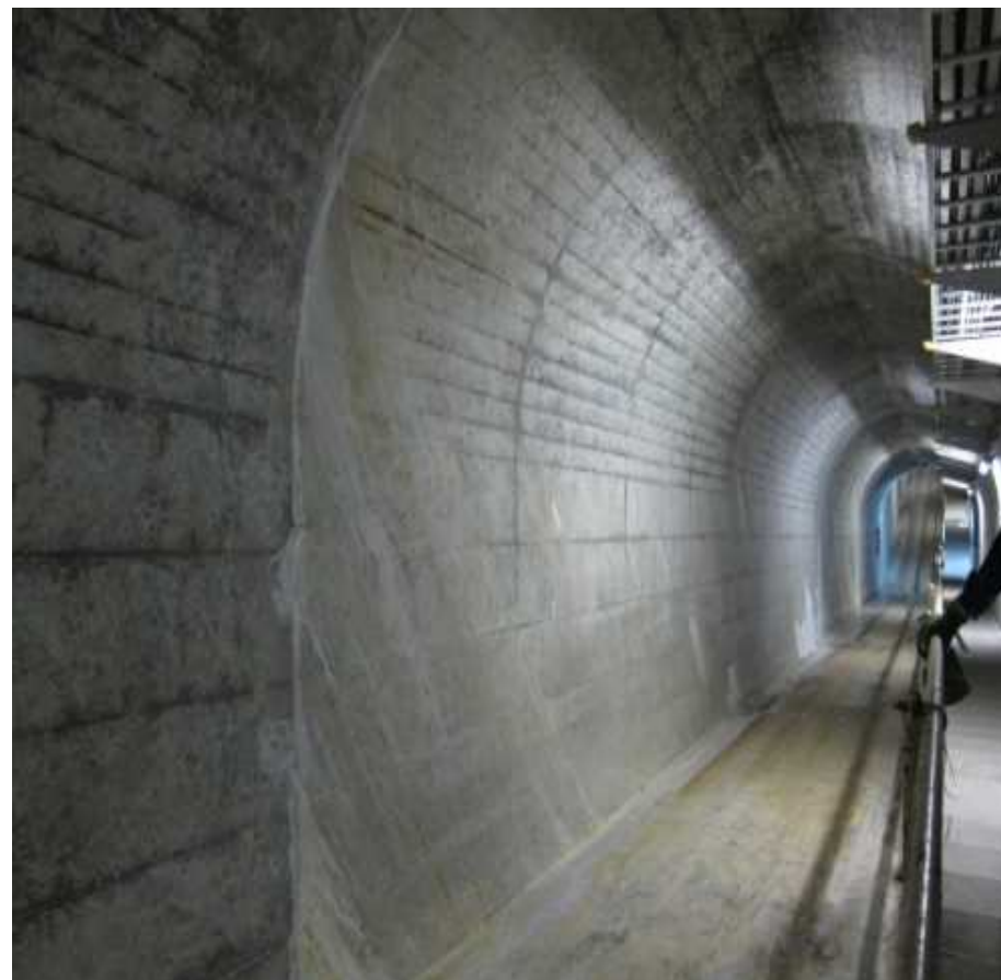
2013年12月（施工後） 漏水なし
