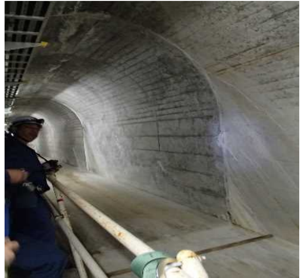
2015年5月（施工後） 漏水なし
