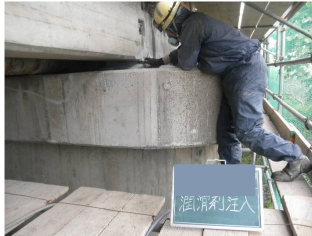
2. 潤滑性防錆剤の注入
