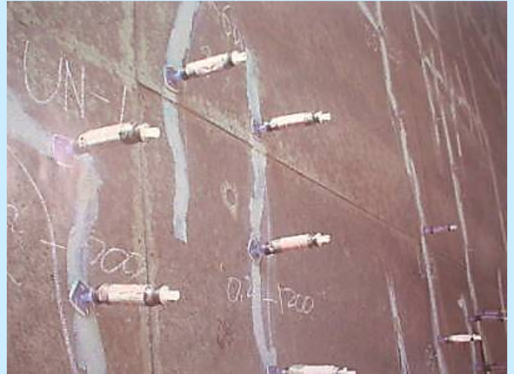
樹脂系注入工法 （低圧注入）
