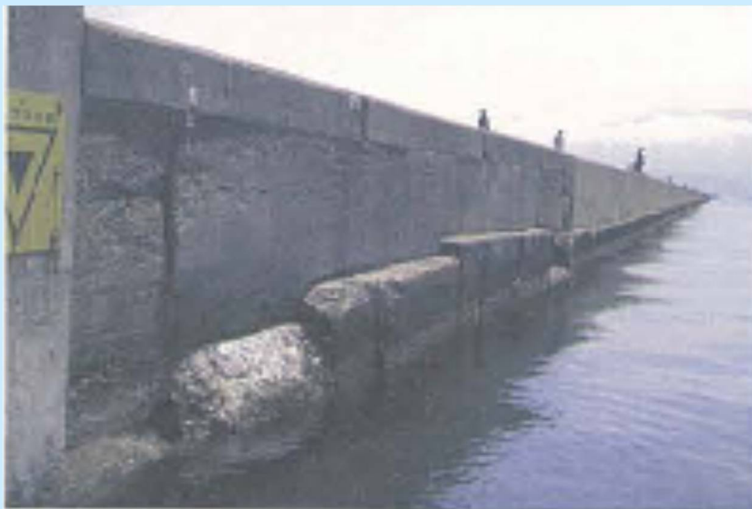
写真-1 明治41年竣工の小樽港北防波堤
