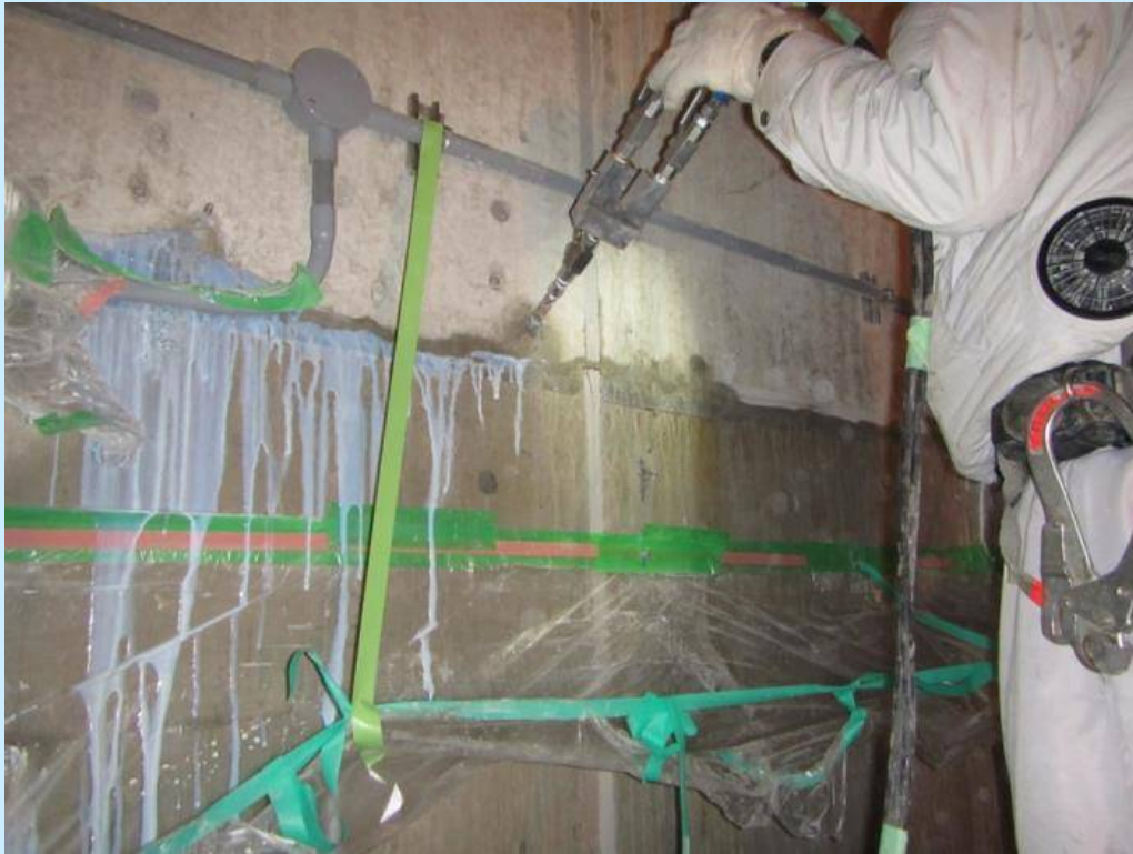
樹脂系注入工法 （中高压注入）
