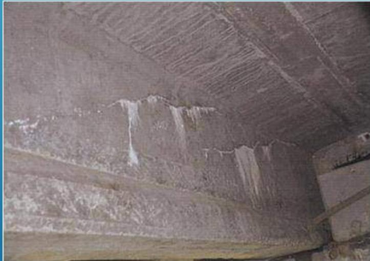
グラウト充填不良により生じたPC鋼材
