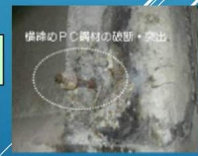
横締め PC 鋼材の破断・突出
