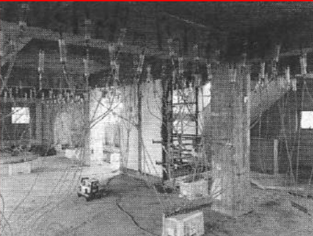
コンクリートに抑制剤を注入して再生中！=青木茂建築工房提供
