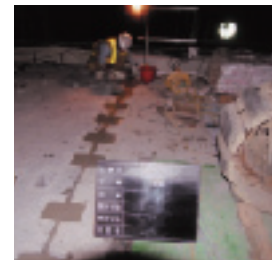
床版継目部 無収縮モルタル打設
