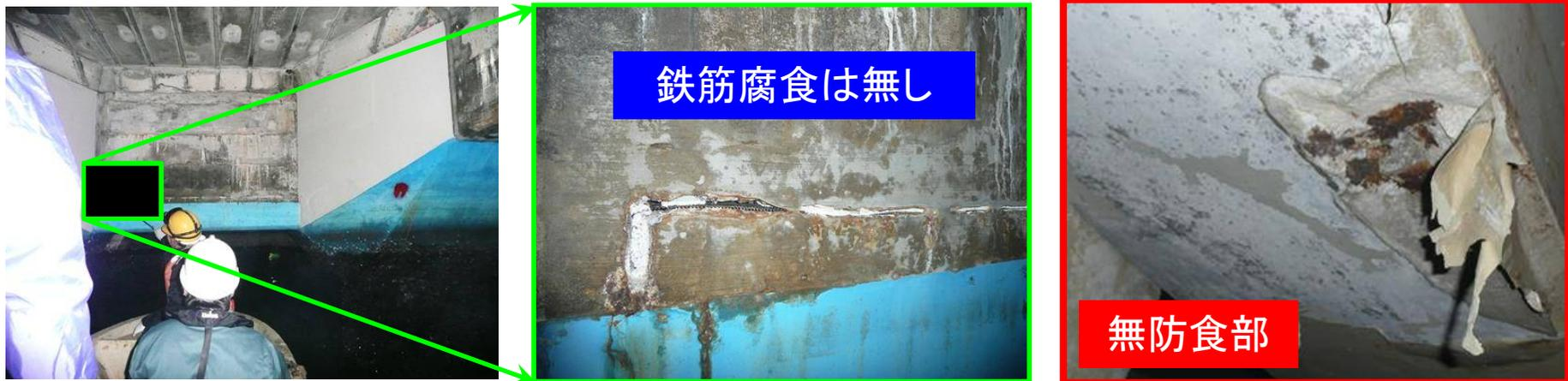
**原因** 外電耐久性陽極による電気化学反応： $\text{H}_2\text{O} \rightarrow 1/2\text{O}_2 \uparrow + 2\text{H}^+ + 2\text{e}^-$
