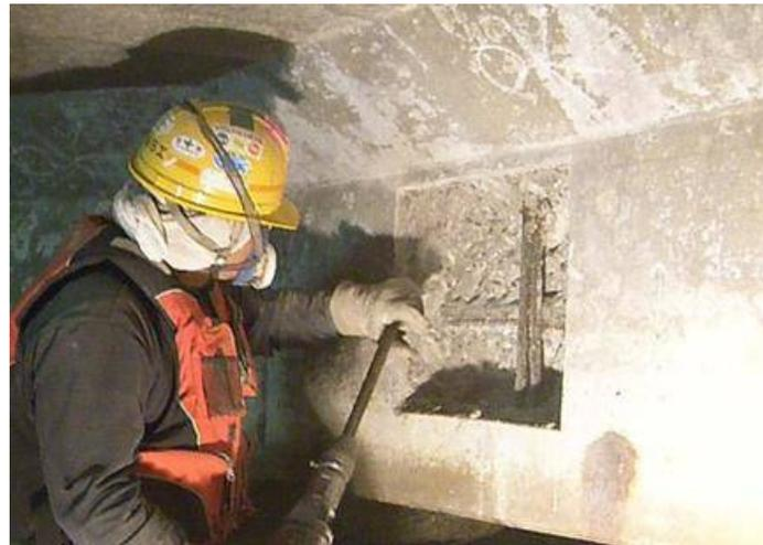
マーキング位置のコンクリートをはつり出し鉄筋を露出させる。
