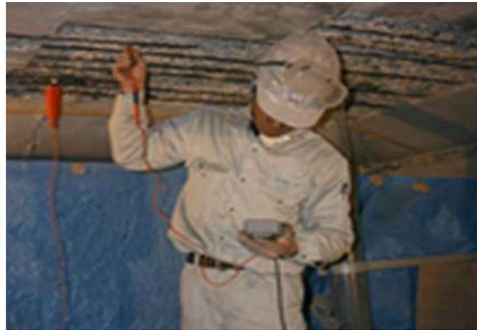
マルチメータを用いて排流線と鉄筋間の導通を確認し、
