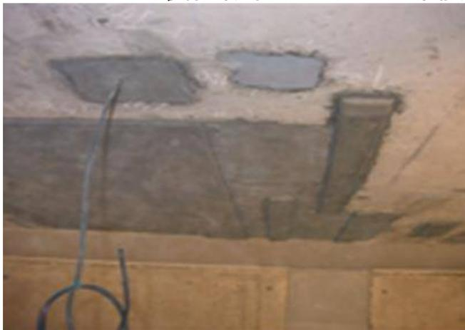
コンクリートと同程度の抵抗率を有する無収縮のモルタルで埋戻す。
