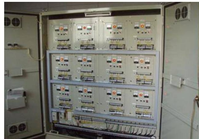
直流電源装置の設置、配線の接続を行う。通電調整試験によって防食電流を決定し、通電する。
