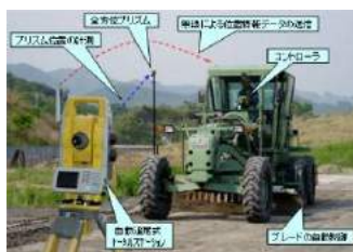
ICT舗装の導入
