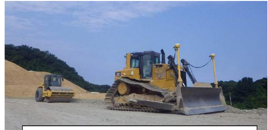
地場の測量機器メーカー等の連携により 後付け機器でICT施工を実施
