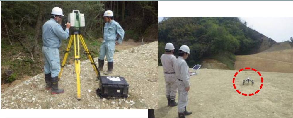
レーザースキャナー、UAVそれぞれの機器で精度確認を実施 両機器とも測定精度は同等。現場での実効性を確認
