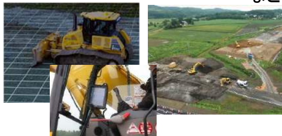
ICT建機での施工
