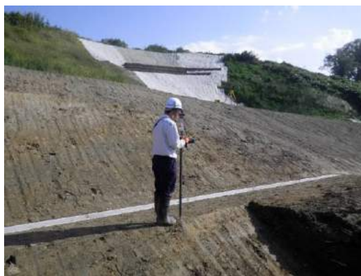
○ 出来形確認の状況
