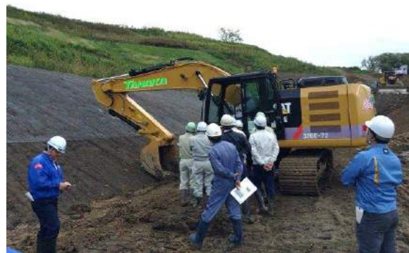
○ ICT技術活用工事現場研修
