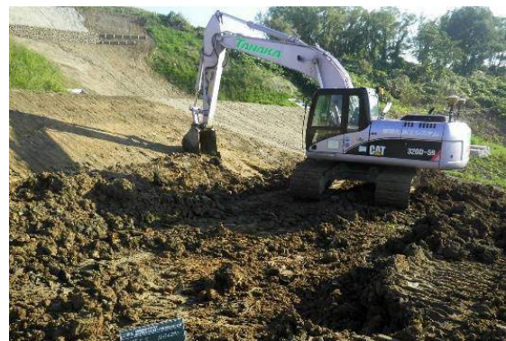
○ ICTバックホウによる法面整形
