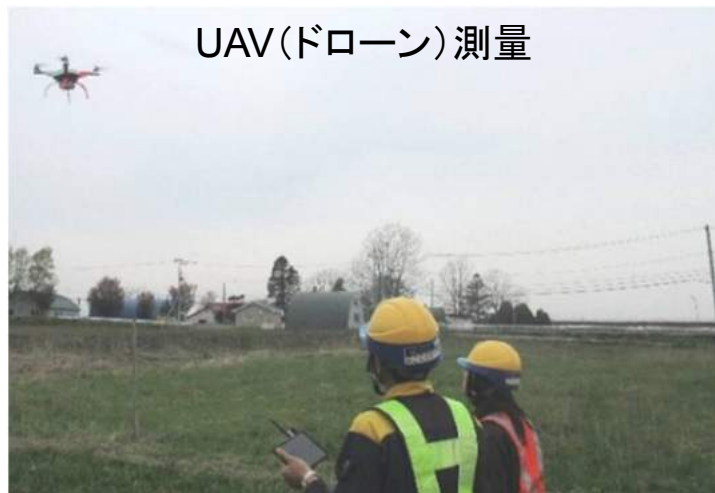
(道央圏連絡道路 泉郷改良工事)
