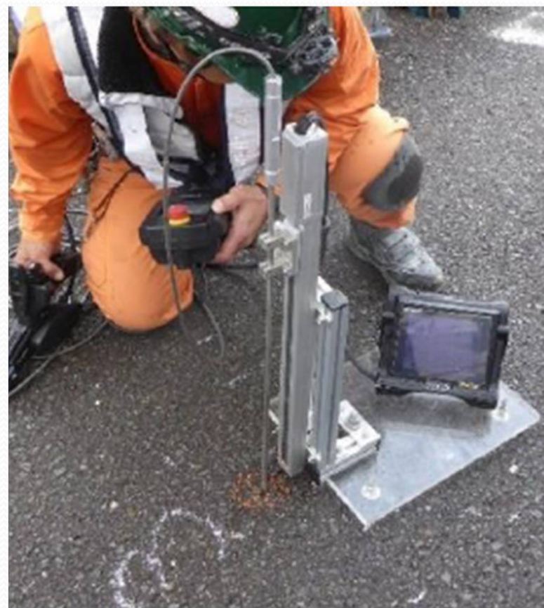
内部の確認と動画記録状況
