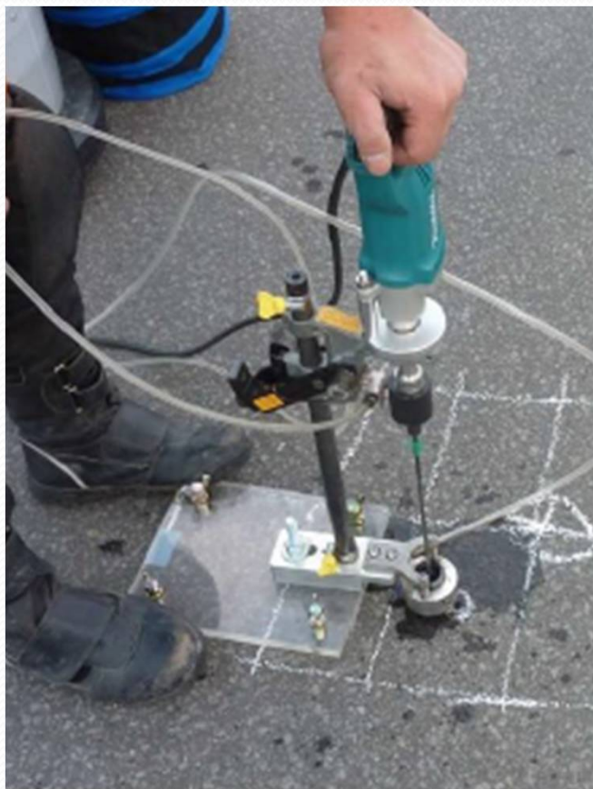
舗装面からの穿孔状況
