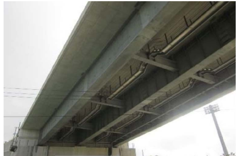
国道329号 宜野座2号橋 鋼3主鈹桁 亜鉛アルミ溶射
