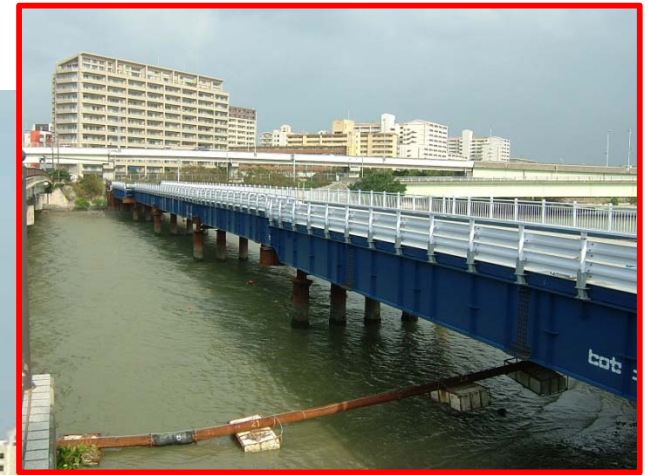
切り回しのための仮橋設置状況
