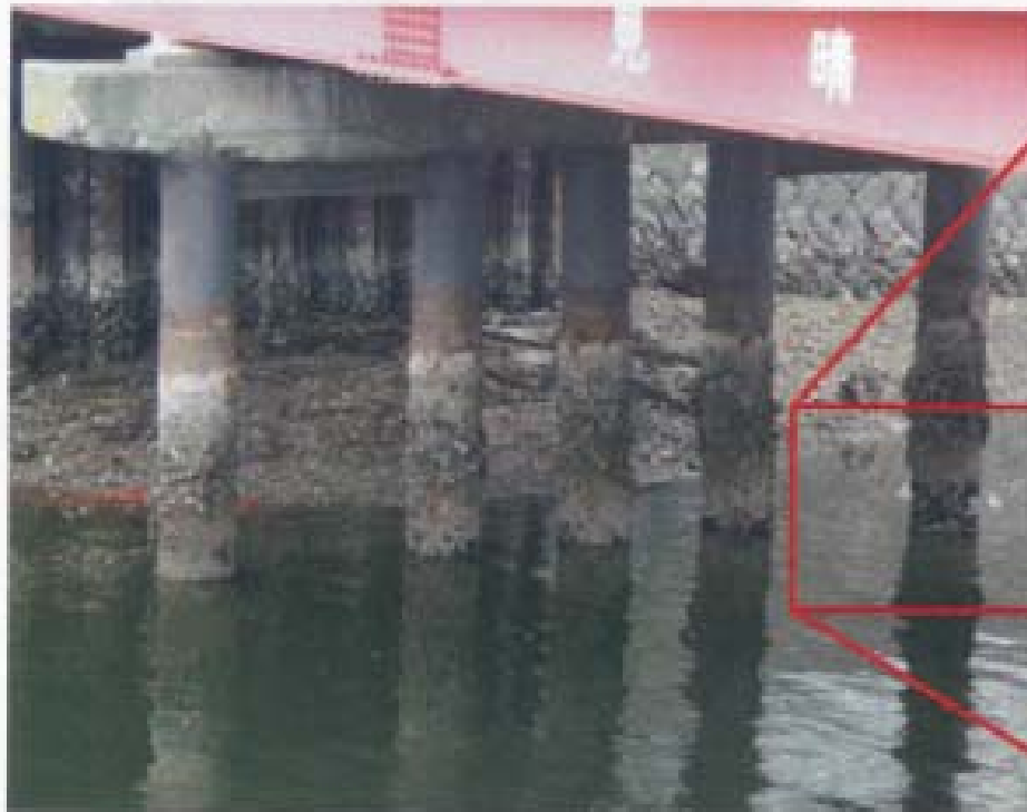
パイルベント基礎
