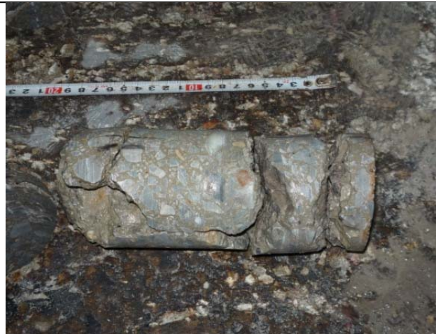
RC床版コアの状況
