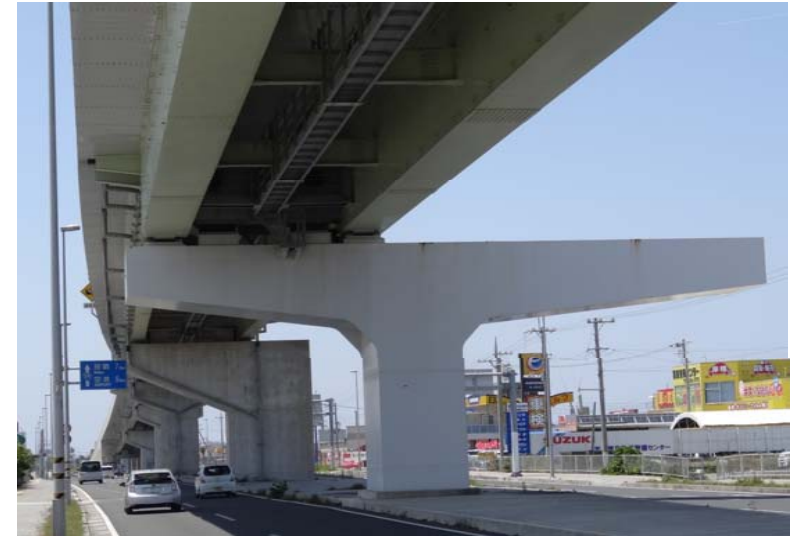
国道506号 ロングランプ橋 鋼細幅箱桁 鋼コンクリート合成床版
