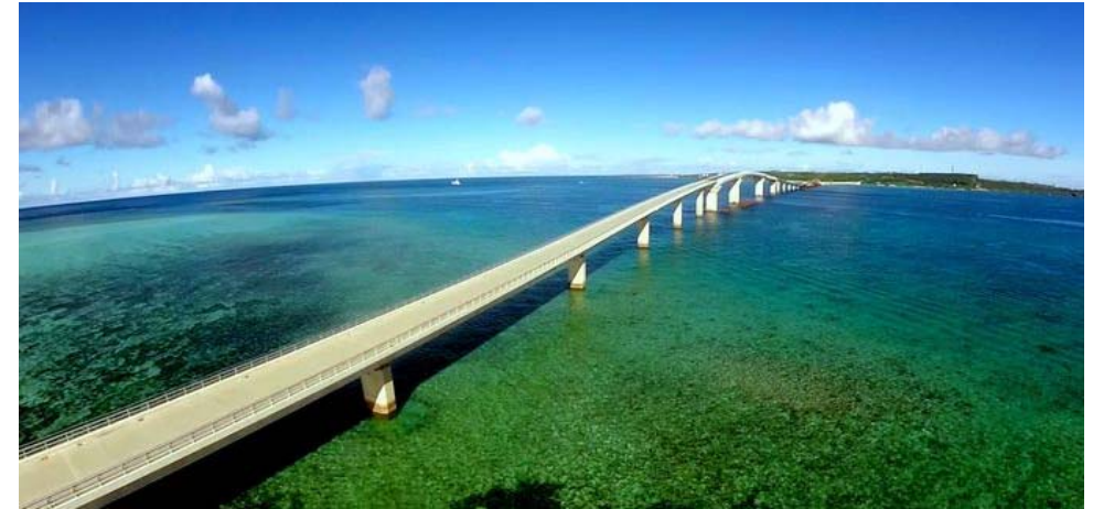
県道 伊良部大橋 PC箱桁橋 フライアッシュ、エポキシ樹脂塗装PC鋼材 ポリエチレンシース、エポキシ塗装鉄筋、 炭素繊維補強材
