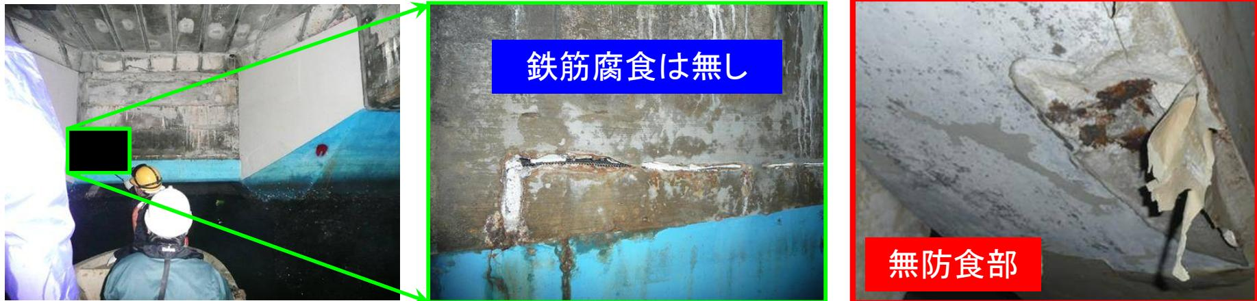
**原因** 外電耐久性陽極による電気化学反応:  $\text{H}_2\text{O} \rightarrow 1/2\text{O}_2 \uparrow + 2\text{H}^+ + 2\text{e}^-$
