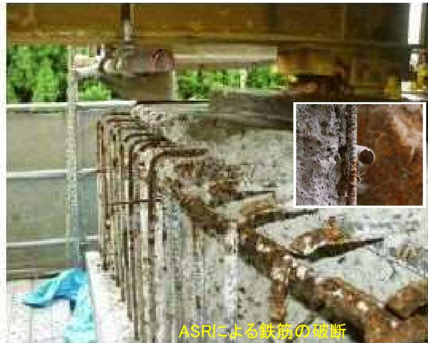
ASRによる鉄筋の破断
