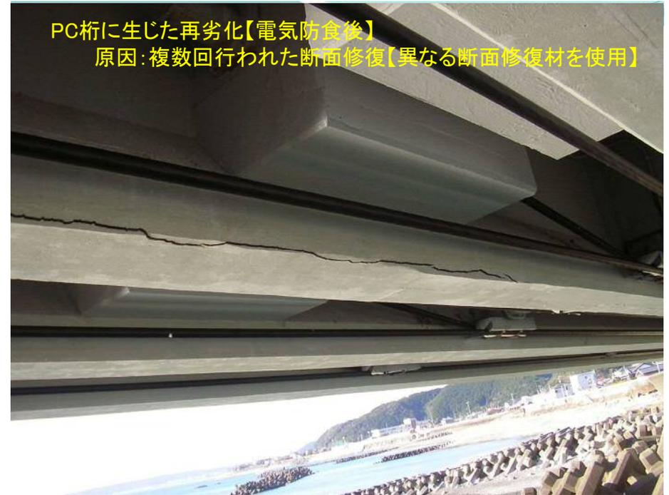
PC鋼材の腐食状況
