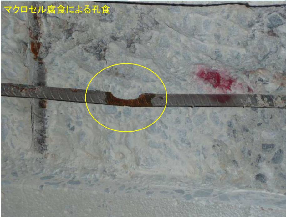
PC桁に生じた再劣化【電気防食後】
