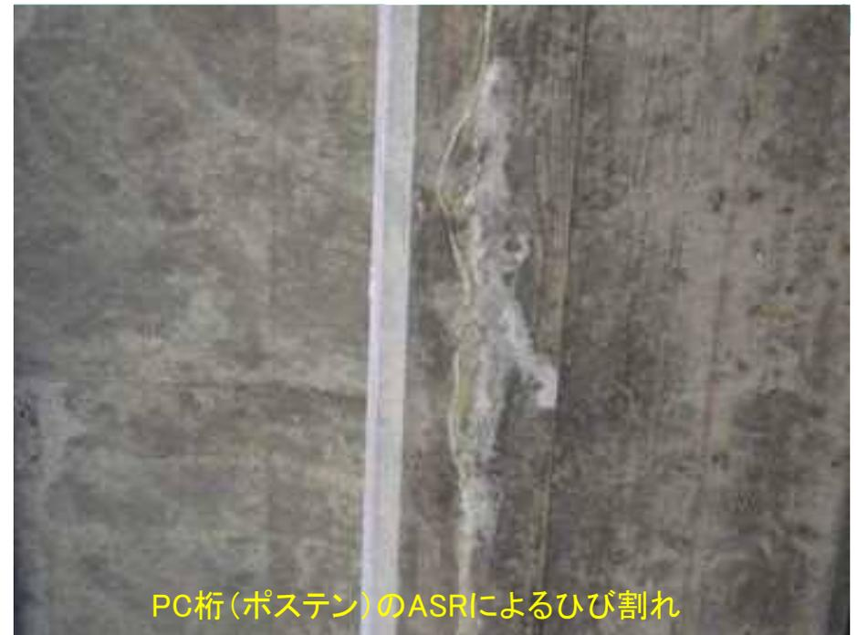
PC桁(ポステン)のASRによるひび割れ
