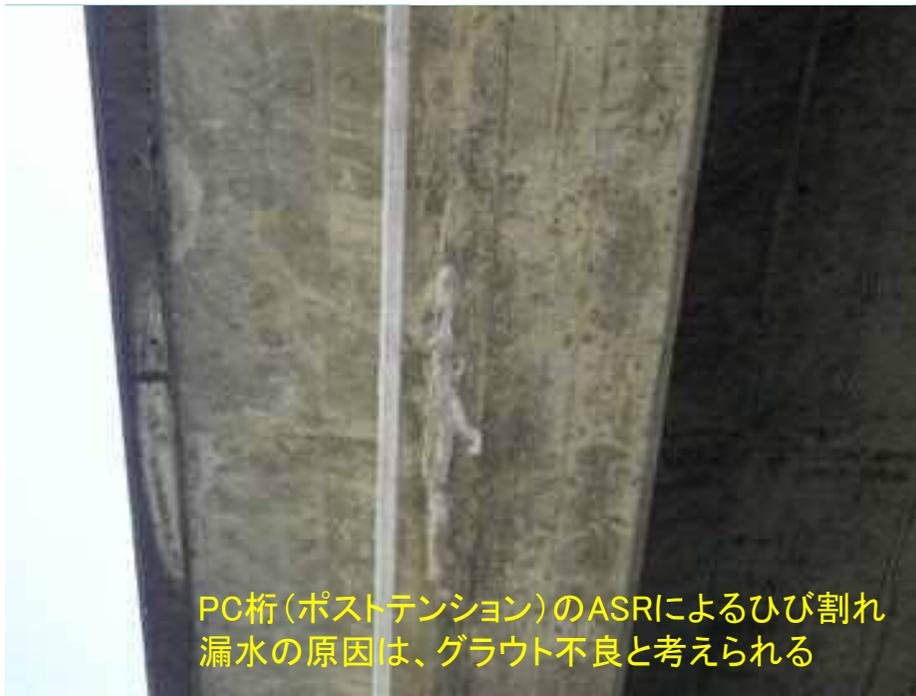
PC桁(ポストテンション)のASRによるひび割れ
