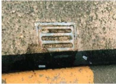
橋面の雨水の排水機能を低下
