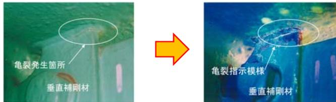
現在発生していなくてもある程度の応力が繰返されている箇所には疲労き裂が発生する可能性がある
