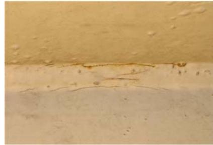
すみ肉溶接部に生じた縦方向の塗膜割れ疲労き裂は、複数のき裂が平行に生じることはないので、塗膜割れの可能性が高い
