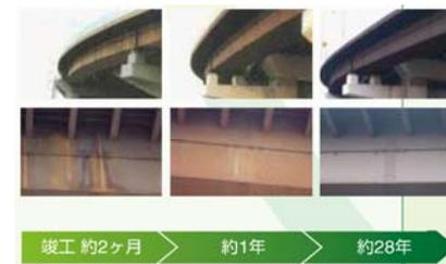
地鉄表面に有効元素が濃縮した緻密なさび層(保護性さび)を形成
