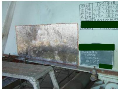
一般的な方法であるが、塗装の粉が飛散するので養生が必要
