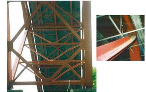
圧縮力側の斜材が面外変形
