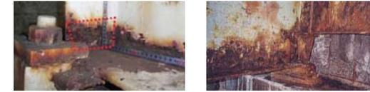
**塗膜劣化**: 塗膜部のみの劣化・損傷(断面欠損を伴わない軽微な錆の発生も含む)
