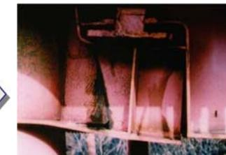
段差の原因—支持桁のき裂
