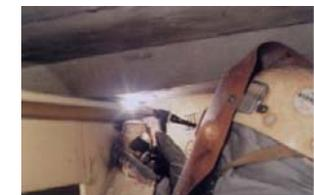
溶接補修+TIG処理
