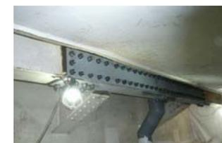
腐食部を切断、部分取替
