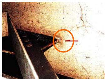
主桁腹板の横構ガセットが**面外力**を受け、ガセットと主桁腹板の溶接止端部から疲労き裂
