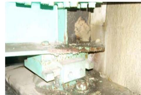
橋梁桁端部の伸縮装置からの漏水による腐食事例
