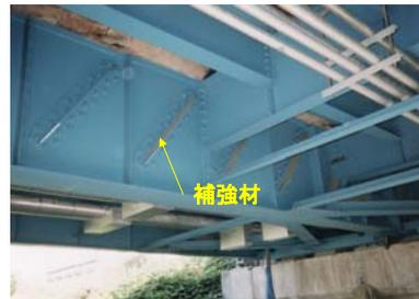
面外変形の矯正およびウェブ補強としてT型材を取付け
