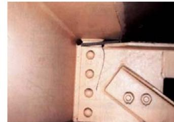
ガセットと対傾構との溶接止端部から疲労き裂が発生
