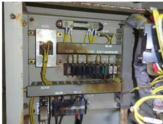
落雷による過大電流で電子部品焼損
