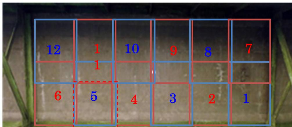
①デジタルカメラ(5,000万画素)と望遠レンズを用いて 床版表面を12分割して撮影
