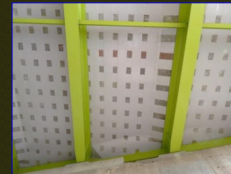
損傷が軽微なうちに炭素繊維を接着することにより、ひびわれを抑制
