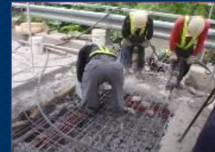
コンクリート床版の打ち替え
