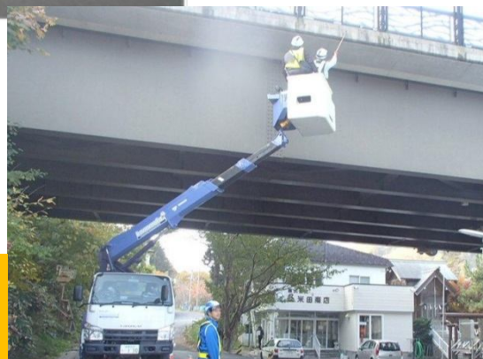
高所作業車 による点検
