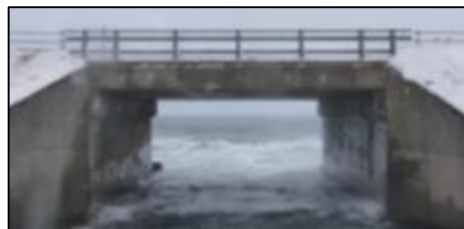
飛来塩分を受ける環境 → 錆汁の滲出は、 腐食・破断 のサイン
