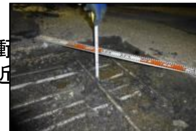
舗装を切削すると、上面損傷
