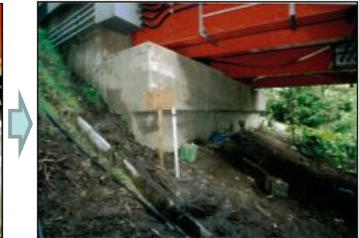
→ 原因は、 地滑り による下部構造の移動
