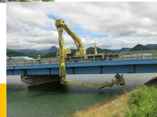
橋梁点検車 による点検
