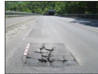
白色析出物や繰り返し補修跡は、床版損傷のサイン
