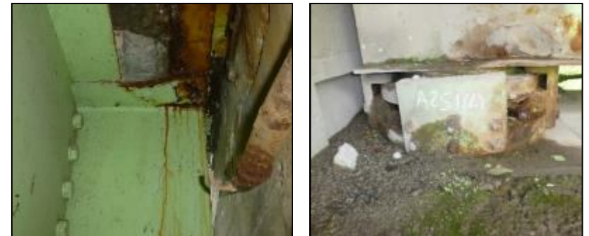
桁の破断 → 原因は、支承の機能障害(沈下)
