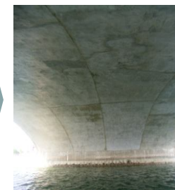
H19修繕後 (断面修復)
