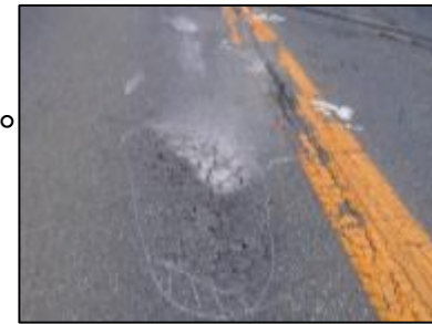
白色析出物や繰り返し補修跡は、床版損傷のサイン
