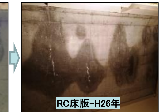
凍結防止剤散布環境 → 鉄筋腐食により 損傷の進行は著しく速い
