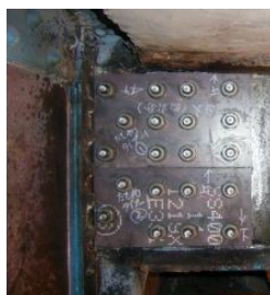
H21修繕後 (主桁修繕)
