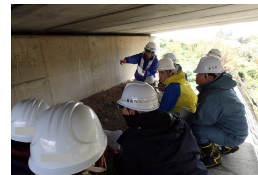
現地研修状況(橋梁)
