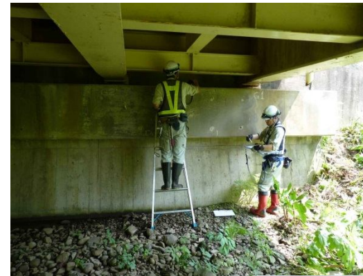
近接目視による点検
