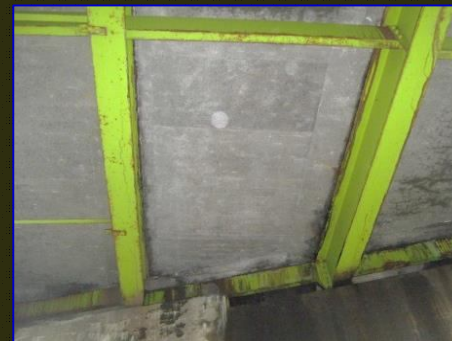
損傷が軽微なうちに炭素繊維を接着することにより、ひびわれを抑制
