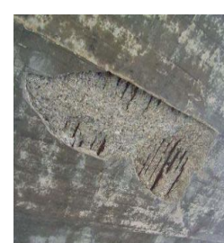
H19損傷状況 (剥離・鉄筋露出)
