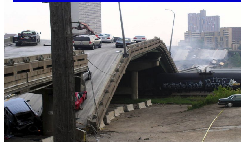
米国ミネソタ州鋼トラス橋崩落事故
