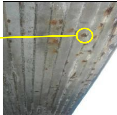
飛来塩分を受ける環境 → 錆汁の滲出は、 腐食・破断 のサイン
