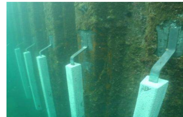
アルミニウム陽極の適用例
