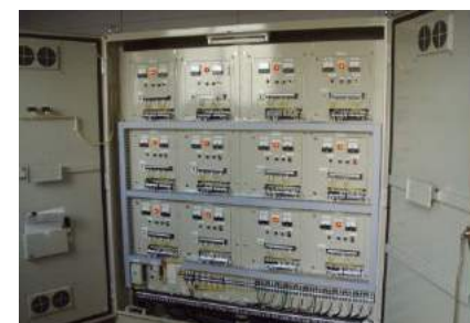
⑧直流電源設置工 電源設置、電流調整
