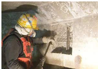
②モニタリング装置設置工 端子取付け部はつり
