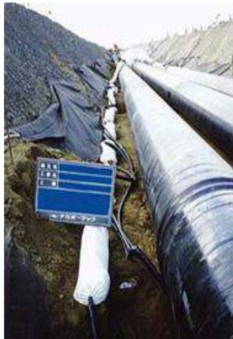
土壌埋設施設
