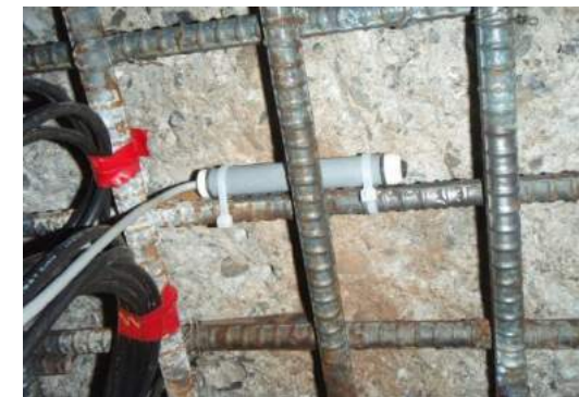
写真は照合電極設置状況(埋戻し前)
