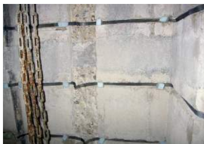
⑥陽極設置工 溝切り、陽極設置、埋戻し
