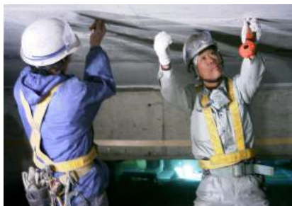
①モニタリング装置設置工 マーキング
