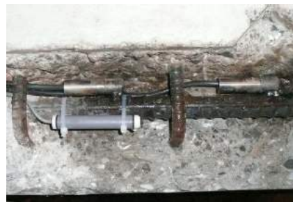
③モニタリング装置設置工 端子類取付け
