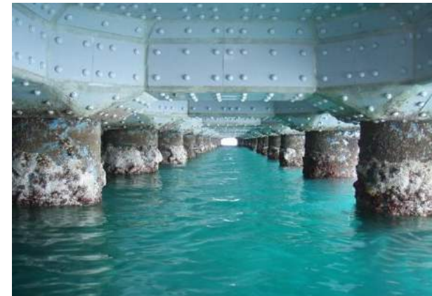
コンクリート構造物
