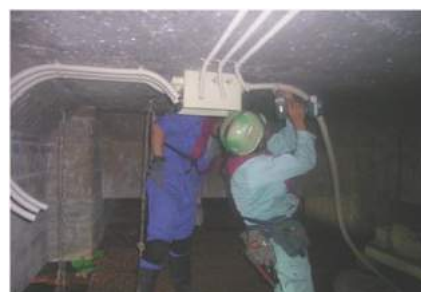
⑦配線配管工 配線配管
