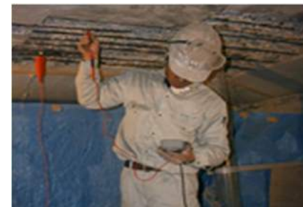
④モニタリング装置設置工 鉄筋間導通確認
