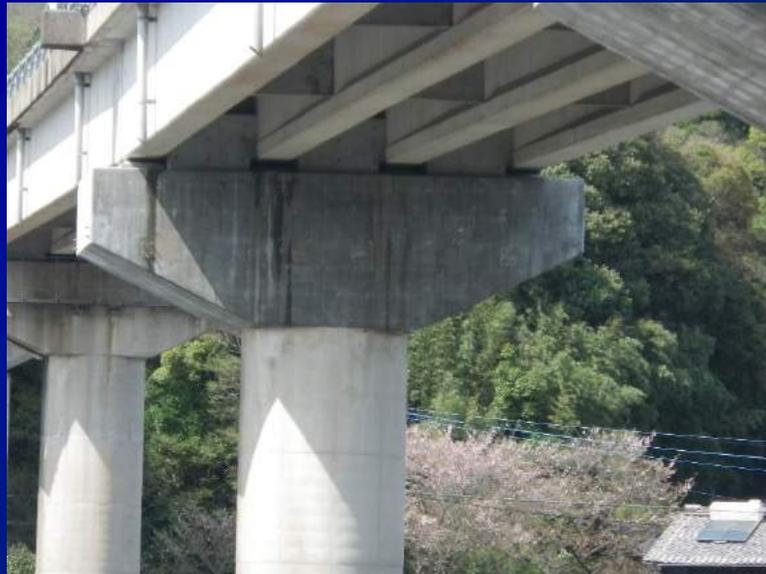
浜玉橋(九州地整) H27度施工(塩害)
