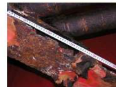
鋼桁の腐食
