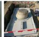
マンホールの浮上防止（新潟市）
