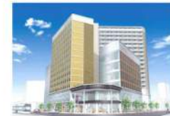
富山市 桜町一丁目地区再開発事業 （商業施設・宿泊施設・住宅の整備）
