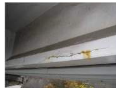
塩害によるコンクリート桁のひび割れ
