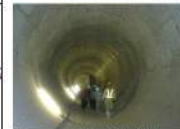
地下に雨水貯留管を整備（新潟市）
