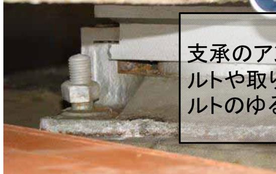
支承のアンカーボルトや取り付けボルトのゆるみ
