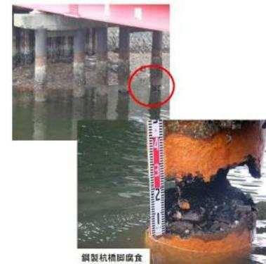
※水中部から調査を実施したところ鋼製杭橋脚に著しい腐食が確認
