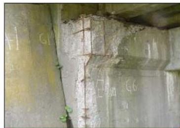
凍害による橋台の剥離
