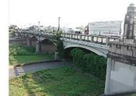
国道1号 鳥羽大橋 6径間連続RCアーチ橋 1934年完成 供用年数79年
