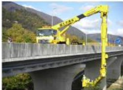
橋梁点検車による点検
