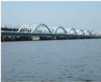
国道43号 伝法大橋(鋼ランガーアーチ橋)
