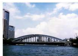
国道1号 桜宮橋 単純鋼リベットアーチ橋 1930年完成 供用年数83年
