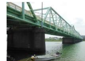
国道42号 天田橋 鋼リベットラス橋 1955年完成 供用年数58年
