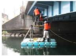
船(フロート)による点検
