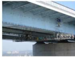
移動式吊足場による点検
