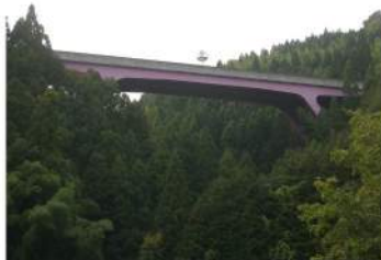
国道27号 塩出橋(3径間連続鋼溶接方柱ラーメン橋)
