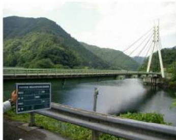
国道29号 カラウコ大橋(単径間鋼斜張橋(箱桁))
