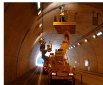
トンネル内道路附属物点検
