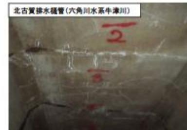
鋼板に遊離石灰、漏水を伴うひび割れ 昭和56年設置(34年経過)
