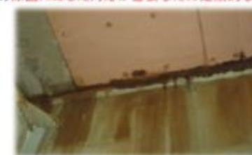
漏水による腐食
